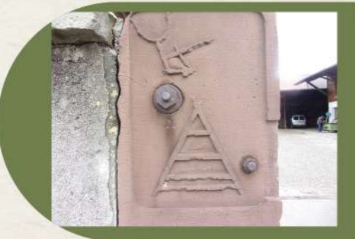
Sur le poteau 1 Grand Rue
