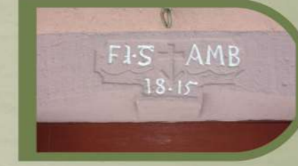
Lintheau de porte - 6 rue de l'église
