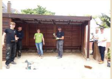
Réparation et peinture abribus bois
